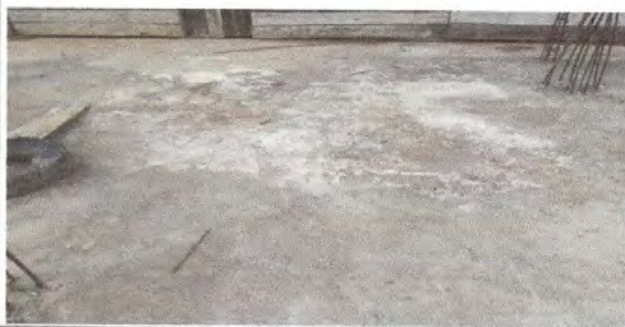
Foto 1: Impermeabilización de losa (terrazza)
