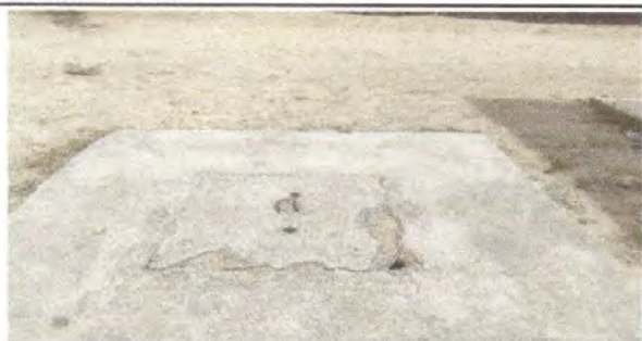
Foto 9: Reparación de tapadera de drenaje y limpieza de fosa séptica 60x60 espesor 10 cm
