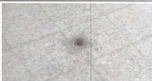
Foto 10: Sustitución reposadera de metal
