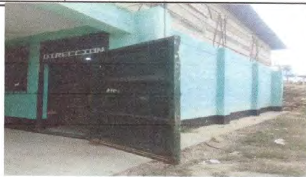
Foto 2: Puertas de metal: mantenimiento de estructura (sujeciones, lijado, aplicación de pintura)
