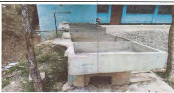
Foto 14: Sustitución e instalación de pilas de concreto de 2 lavaderos
