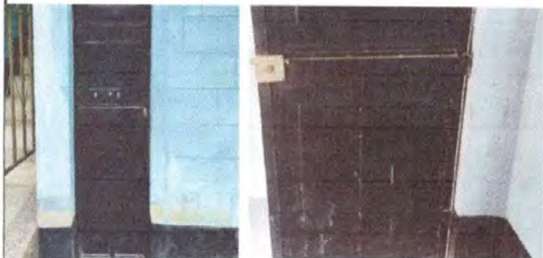
Foto 3: Sustitución de chapa
