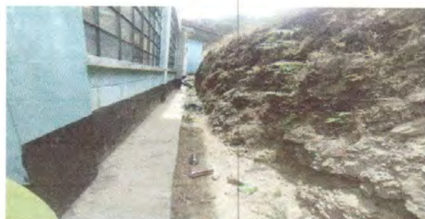
Foto 4: Reparación de cuneta
