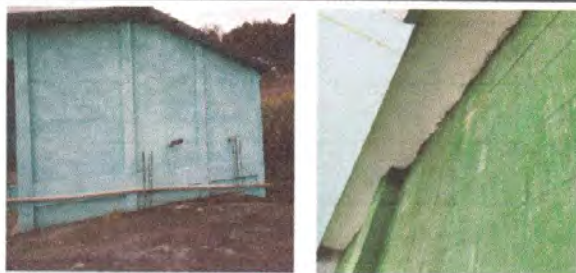
Foto 5: Pintura en muros exteriores e interiores
