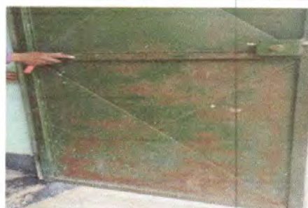
Foto 6 : Mantenimiento a estrura (sujeciones, lijado, aplicación de pintura) a puerta de servicio sanitario
