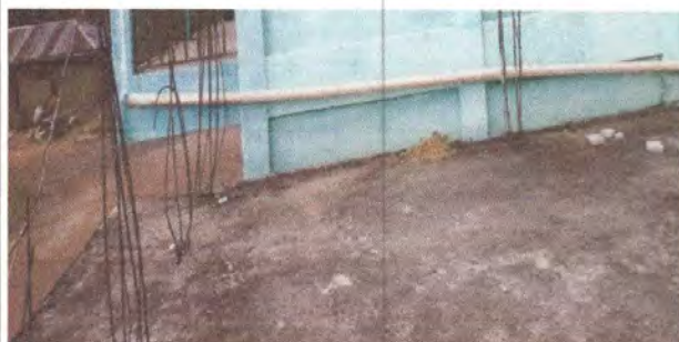
Foto 8: Sustitución de tuberías PVC línea principal aguas pluviales (codos 2" y pegamento)
